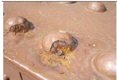
Falla por corrosión de un bulón en un puente.
