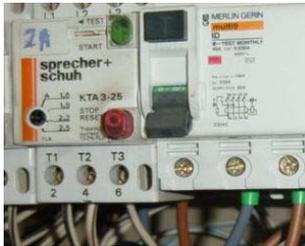
El más utilizado es la **puesta a tierra de las masas asociadas a interruptores diferenciales**. Basan su funcionamiento en la asociación entre las puestas a tierra y dispositivos de corte automático, de forma que, cuando se alcancen corrientes de fuga peligrosas, se origine la rápida desconexión de la instalación defectuosa.
